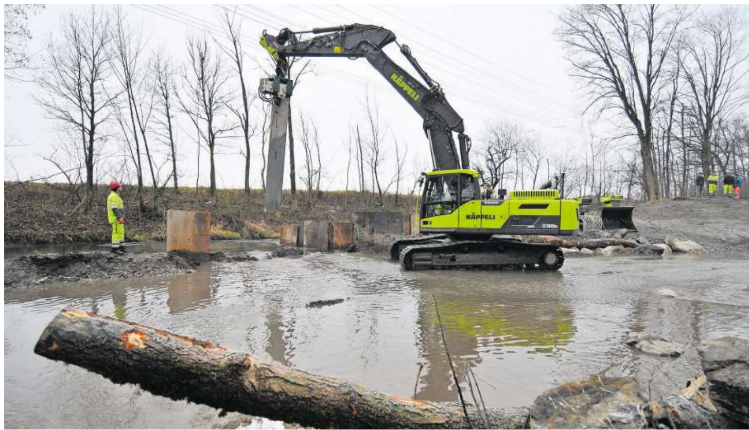
Der Bagger hebt die Spundwände und leitet das Wasser um in den neuen, renaturierten Bachlauf.
