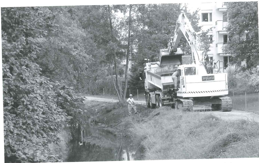
Renaturierungsarbeiten am Wettibach: Mit schwerem Baugerät wird die Böschung neu strukturiert.
