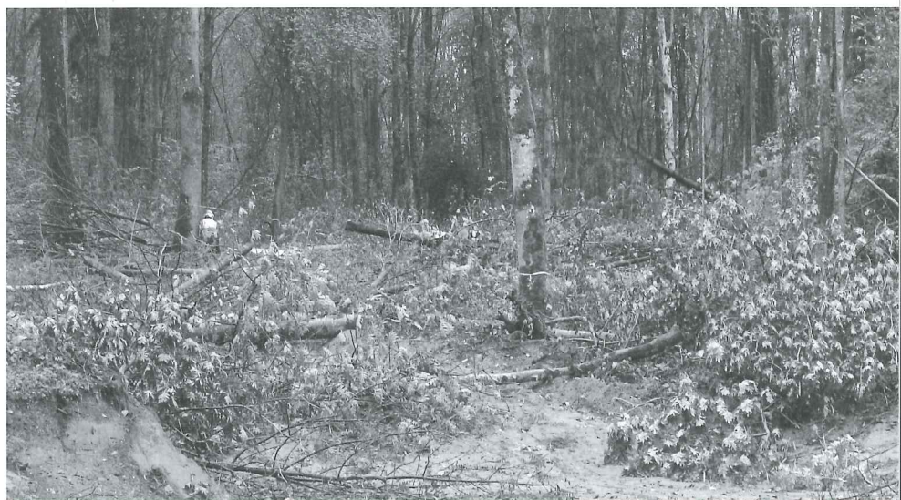
Der Werdenberger Binnenkanal fliesst künftig mitten durch den Wald: Bevor die Baumaschinen auffahren, werden einzelne Bäume gefällt.
