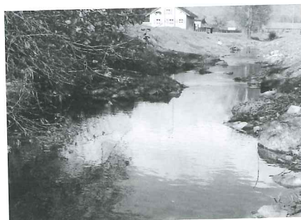
Nach Abschluss der Arbeiten
