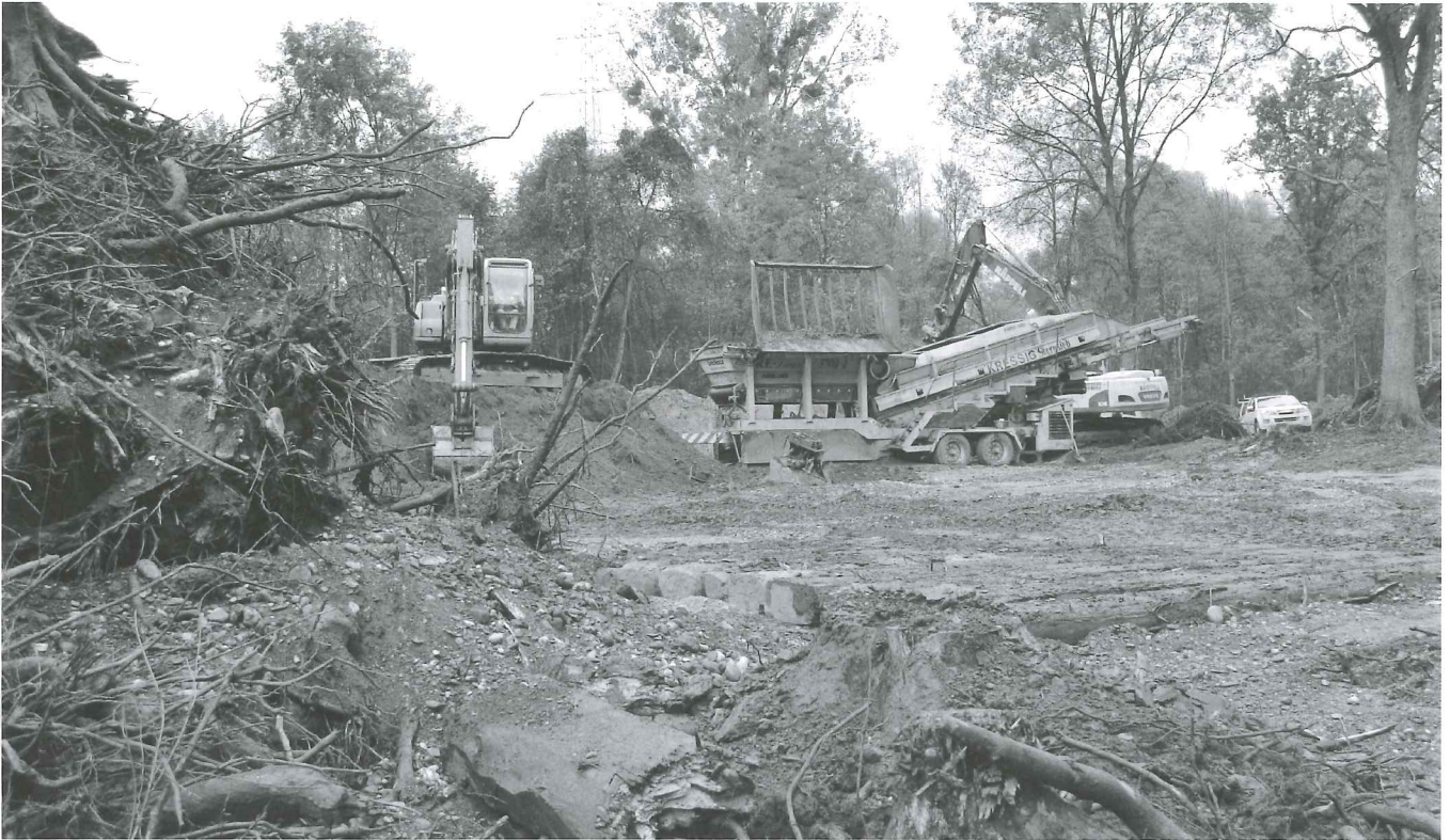
Grosse Veränderung: Ein Teil der Bäume bleibt als Gestaltungselement des neuen Werdenberger Binnenkanals stehen, Totholz wird als Unterschlupf für Kleinlebewesen dienen.
