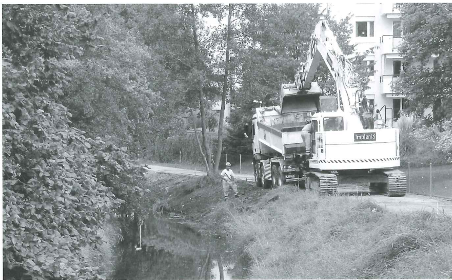
Renaturierungsarbeiten am Wettibach: Mit schwerem Baugerät wird die Böschung neu strukturiert.
