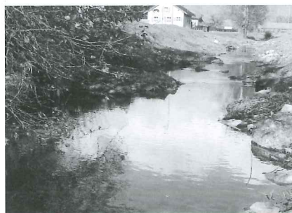
Nach Abschluss der Arbeiten
