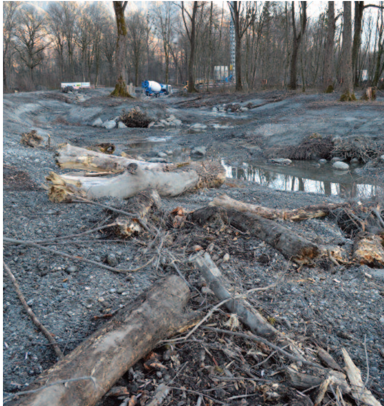
Noch ist es relativ trocken. Am kommenden Mittwoch wird die Gewässereinleitung in das neue Bett des Werdenberger Binnenkanals stattfinden. FOTOS: ZVG
